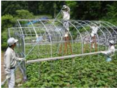
第20図：普及型光触媒温室の組立
