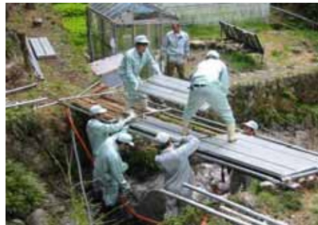
第40図：橋の架け替え作業
