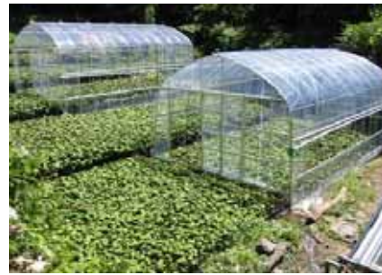
第21図：建設した普及型光触媒温室
