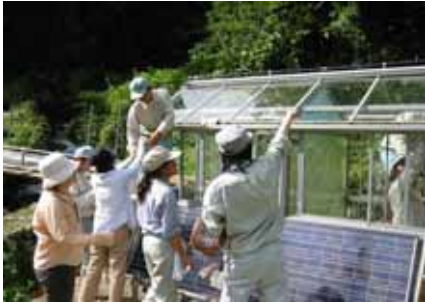
第10図：温度計設置中の光触媒ガラス温室
