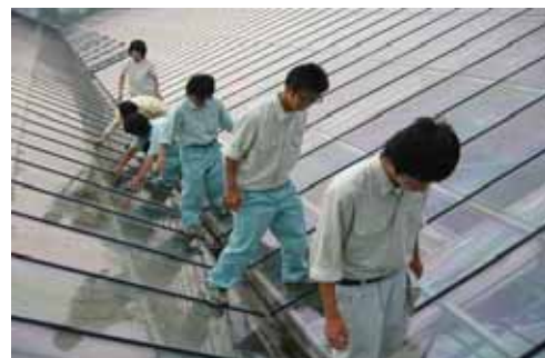
第38図：大型ガラス温室の屋根での散水確認
