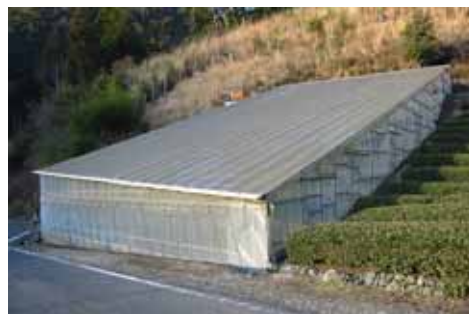
第42図：光触媒塗布を検討している大型温室
