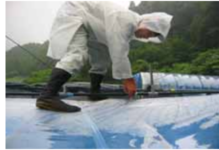
第30図：散水ホースの取り付け作業
