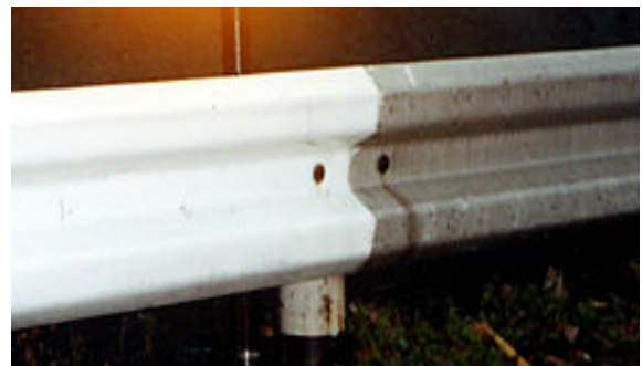
酸化チタン光触媒塗料を塗装したガードレール
